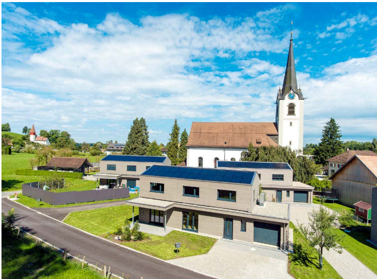
In Uttwil entstehen ECOCELL ECO-Solar-Häuser mit Solardach.
